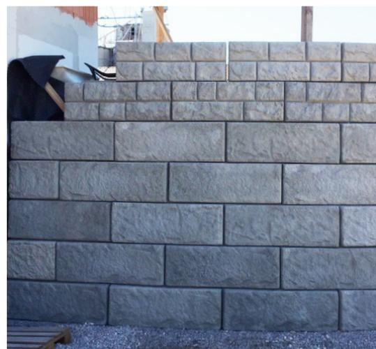
Das SW-Stützwandsystem wurde in Ried im Traunkreis als Absicherung eines steilen Hanges errichtet und die ebene Fläche für den Gartenbereich und die Neuerrichtung eines Wohnhauses konnte dadurch vergrößert werden.
