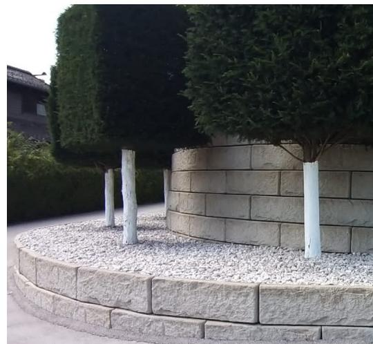
Bei dem Projekt in Lind ob Velden wurde eine bestehende Einfassungsmauer mit dem SW-Stützwandsystem um eine Steinreihe erhöht.
