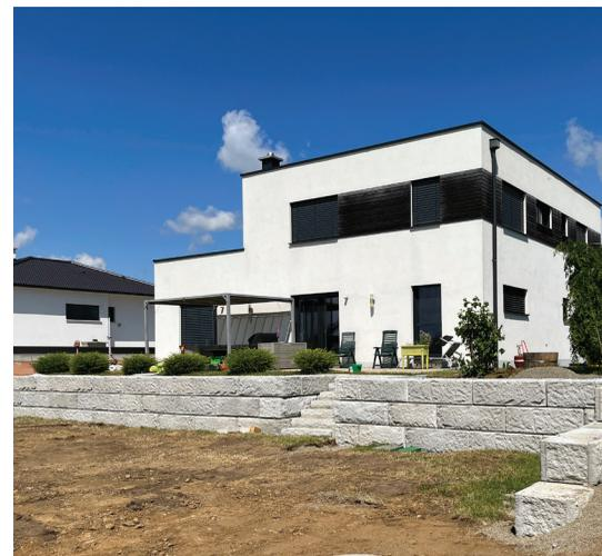
Im Klein-Pöchlarn wurden bei einem Einfamilienhaus verlaufend drei Stützwände errichtet und zusätzlich zwei Stufenaufgänge mit eingebunden. Auf der Vorderseite des Hauses sind vorwiegend Vollblocksteine mit beidseitiger Sicht in Verwendung.
