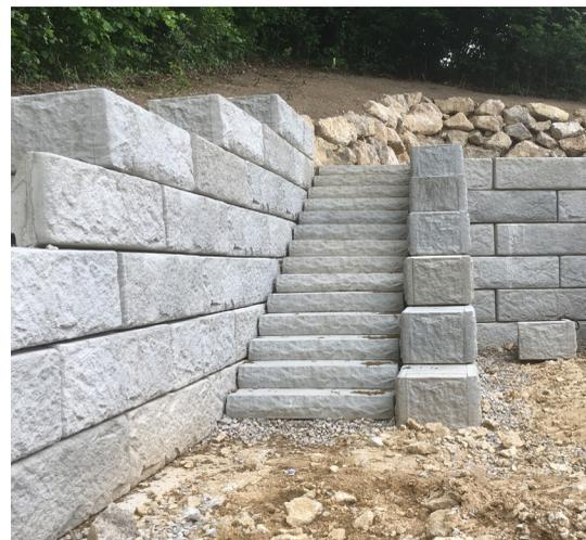
Im Garten eines Einfamilienhauses in Hinterbrühl wurden zwei Stützwände errichtet. Die erste Stützwand dient zur Abstützung des vorderen Gartenbereichs und Schaffung einer ebenen Fläche, die Zweite wurde mit einem Stufenaufgang kombiniert.
