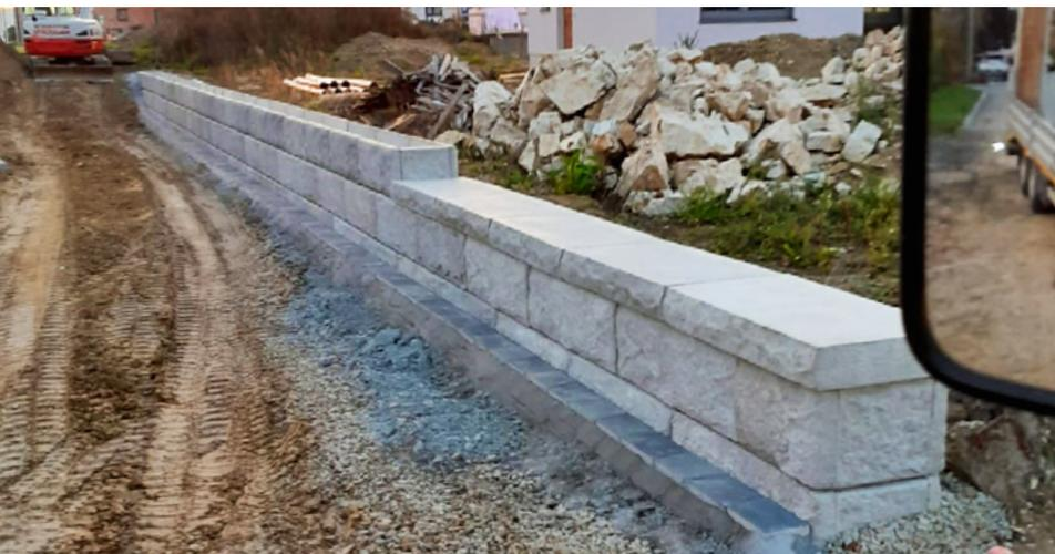
Bei dem Projekt in Großgerharts wurde eine SW-Stützwand mit Abschluss-Abdeckplatten sowie U-Trögen errichtet.
