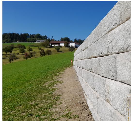
Bei dem Privathaus in Gramastetten wurden mit dem SW-Stützwallsystem zum Ausgleich eines Niveauunterschiedes mehrere Terrassen geschaffen. Die SW-Stützwallsystem Stufenplatten fügen sich dabei hervorragend in die geschaffenen Terrassen ein.
