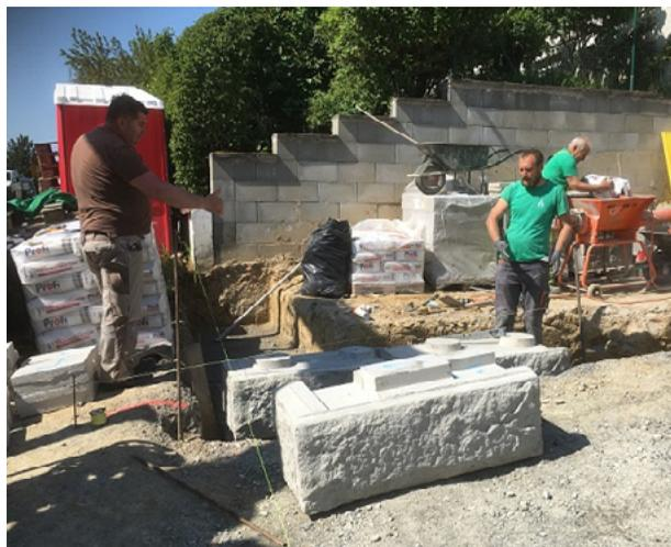
Bei einem Privathaus in Donnerskirchen wurden mehrere Wände mit dem SW-Stützwandsystem errichtet. Drei Wände sind freistehend mit Vollsteinen ausgeführt und weisen beidseitige Sichtflächen auf. Die zwei weiteren Wände sind als Stützwand mit entsprechender Hinterfüllung ausgeführt.
