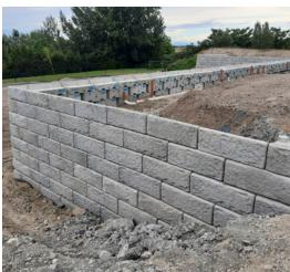
Für den Neubau eines Kunstrasenplatzes in Lassee wurde eine Stützwand errichtet. Um eine schnelle Umsetzung gewährleisten zu können, wurde das SW-Stützwandsystem gewählt. Die Mauer wurde auf ein Ortbetonfundament aufgesetzt und auf eine Höhe von 410 cm aufgebaut. In Summe wurden 595 Betonblöcke verbaut.
