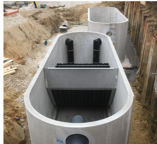
Das Projekt sieht die Entwässerung eines Freiflächen Rastplatzes über eine Gewässerschutzanlage vor. Diese besteht aus einem Drosselschacht, Vorabscheider (Lamellenklärer) und ovalem Filterbecken für eine weitergehende Reinigung über technisches Filtermaterial (SW-AQUAfilt-F3).
