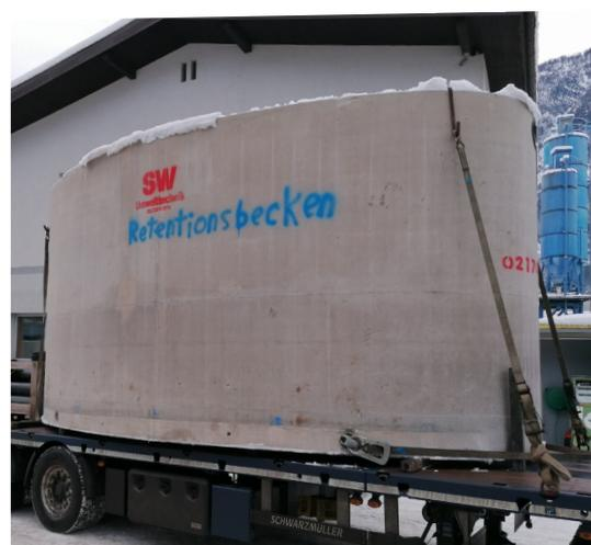
Für das Projekt in Stockenboi wurden Behälter als Anlageteile einer Kläranlage geliefert und versetzt. Im Pufferbecken wird der unterschiedliche Tages-Abwasserzufluss aufgefangen und nur in der Beschickungsphase dem SBR-Reaktor zugeführt. Aus dem elliptischen Retentionsbecken erfolgt der gedrosselte Ablauf in den Vorfluter.
