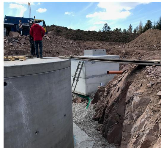
Bei diesem Projekt wird das Abwasser von einem Hotel und einem bekannten Ausflugsgasthaus gesammelt und in einer Kläranlage in Großbeckenbauweise gereinigt. Die maschinelle Ausrüstung erfolgte über ein Ingenieurbüro.
