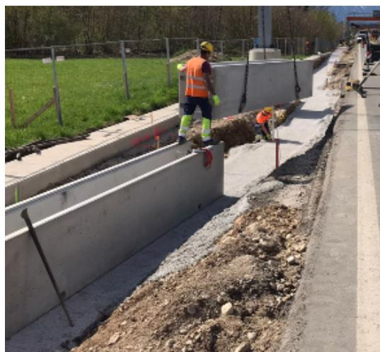
Im Zuge der Bauarbeiten an der A1 RFB Wien Abschnitt AST Salzburg West bis HAST Siezenheim wird die bestehende Oberflächenentwässerung adaptiert und neu gestaltet. Neben der Errichtung einer Gewässerschutzanlage erfolgt auch die Errichtung eines offenen Gerinnes in Rechteckquerschnitt über eine Länge von 630m. Die Ausführung des offenen Gerinnes erfolgt in Betonfertigteilen.
