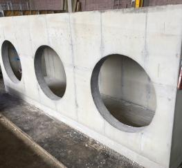
In Köstendorf wurde bei der Zufahrt und Anbindung der Freiwilligen Feuerwehr Zu- bzw. Ablaufbauwerke der Retentionsanlage errichtet.
