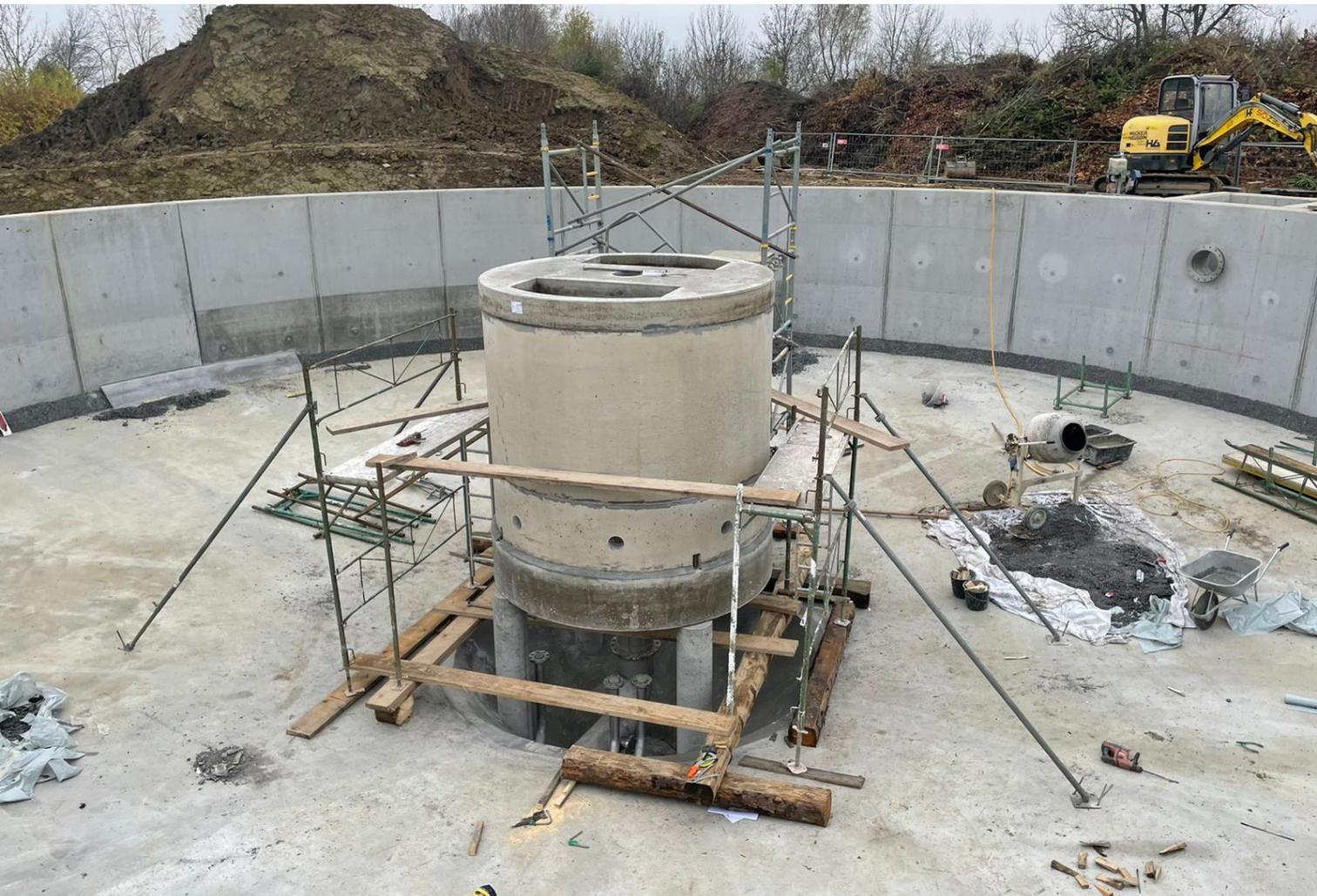
Das Projekt sieht die Errichtung eines Mittelturms beim Nachklärbecken der Kläranlage Eggenburg-Röschitz vor. Der Mittelturm ist eine Kombination von Ortbetonstützen, worauf ein aus Fertigteile hergestellter Schachtteil mit einer Wandstärke von 19 cm in 2-teiliger Ausführung sowie zusätzlicher Flachabdeckung aufgesetzt und mit der Ortbetonstütze vergossen wird.
