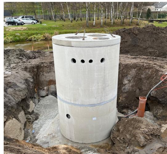
Für das Hochwasserschutzprojekt in Gmünd wurden verschiedene Rundbecken für Pumpwerke (Hebeanlagen) errichtet und geliefert. Die Flachabdeckungen wurden mit ebenbündig eingelegten Einstiegsdeckeln gefertigt.
