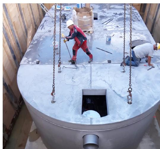
Das Projekt sieht die Entwässerung der ergänzenden Teilflächen des ÖBB Containerterminal Wien-Inzersdorf vor. Die Oberflächenwässer vom Containerlagerplatz werden Abschnittsweise gesammelt und über Verkehrsflächensicherungsschächte gereinigt und abgeleitet.
