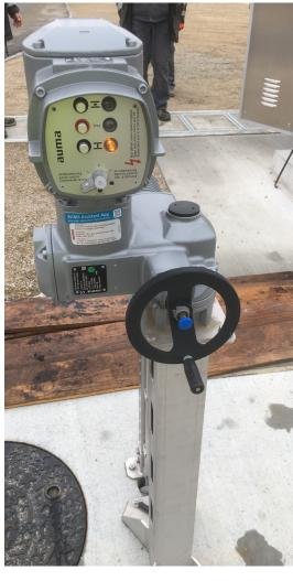
Bei dem Projekt wurde eine Trafogruben-Entwässerung beim Umspannwerk Neusiedl an der Zaya errichtet. Die anfallenden Oberflächenwässer aus den Trafogruben werden über einen Schieberschacht mit automatischen Schieber, nachfolgenden Mineralölabscheider und anschließendem Pumpwerk nach vorhergehender Kontrolle durch das Betriebspersonal durch eine automatische Reinigungsanlage entwässert.
