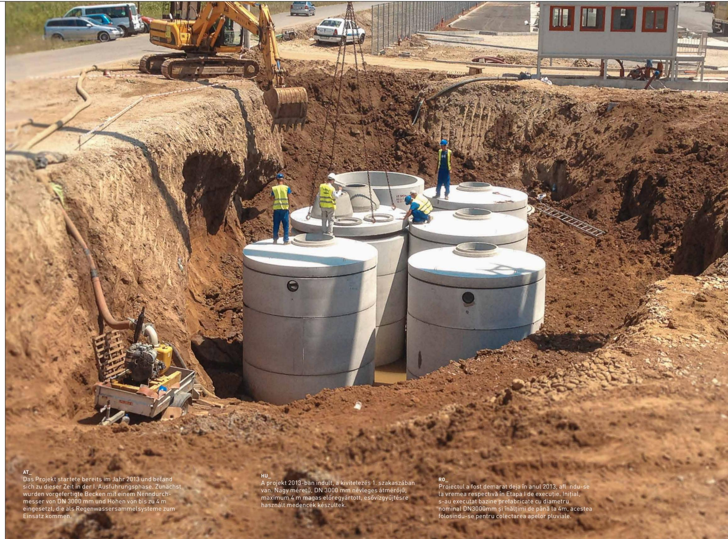
AT\_ Das Projekt startete bereits im Jahr 2013 und befand sich zu dieser Zeit in der I. Ausführungsphase. Zunächst wurden vorgefertigte Becken mit einem Nenndurchmesser von DN 3000 mm und Höhen von bis zu 4 m eingesetzt, die als Regenwassersammelsysteme zum Einsatz kommen.
