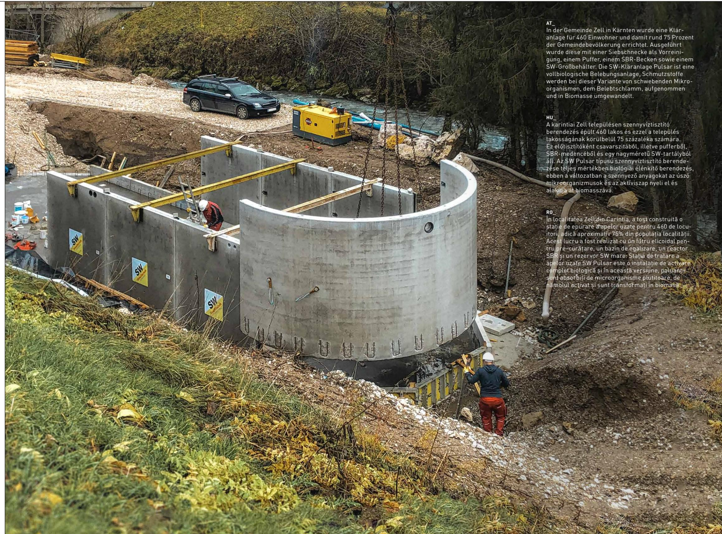
AT\_ In der Gemeinde Zell in Kärnten wurde eine Kläranlage für 460 Einwohner und damit rund 75 Prozent der Gemeindebevölkerung errichtet. Ausgeführt wurde diese mit einer Siebschnecke als Vorreinigung, einem Puffer, einem SBR-Becken sowie einem SW-Großbehälter. Die SW-Kläranlage Pulsar ist eine vollbiologische Belebungsanlage, Schmutzstoffe werden bei dieser Variante von schwebenden Mikroorganismen, dem Belebtschlamm, aufgenommen und in Biomasse umgewandelt.
